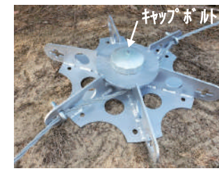
⑨キャップボルト取付—施工完了
