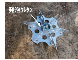
②プレート基盤据付
