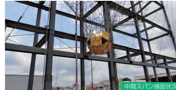
中間スパン捕捉状況
