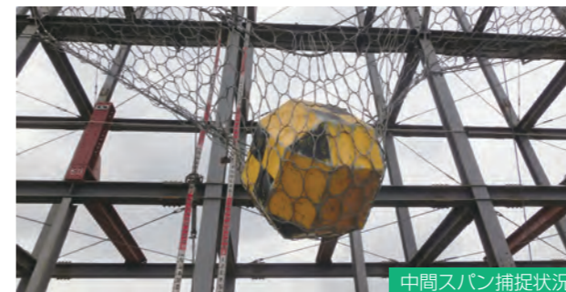
中間スパン捕捉状況
