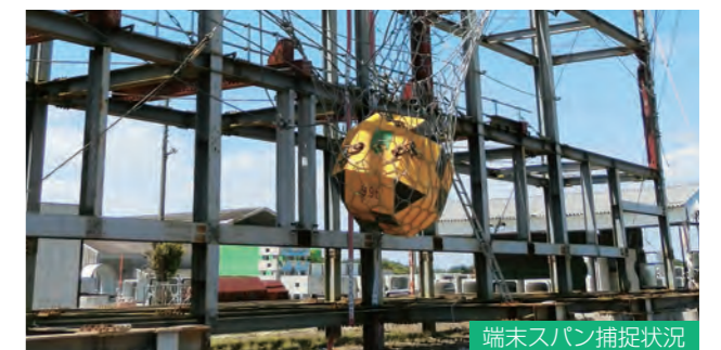
中間スパン捕捉状況
