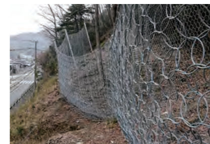
落石を包み込みエネルギーを吸収するASMネット
