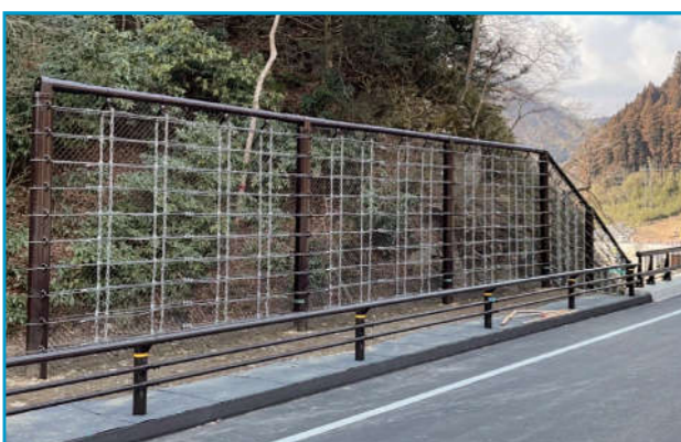
発注者 福島県いわき建設事務所 工事件名 道路橋りょう整備(再復)工事(道路改良) 施工箇所 福島県いわき市田人町住字才鉢地区 施工延長 18m 落石エネルギー 135kJ
