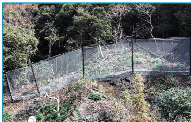
発注者 福井県丹南土木事務所 工事件名 道路防災対策工事2-3-51 施工箇所 福井県丹生郡越前町梨子ヶ平地係 施工延長 30m 落石エネルギー 124kJ
