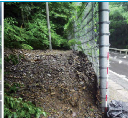
2020年 鹿児島県 土砂堆積高さ: 2.0m 土砂推定堆積量: 72m 3 捕捉後の状態: 性能1(土砂捕捉による変形・損傷は軽微で、構成部材の交換なし)
